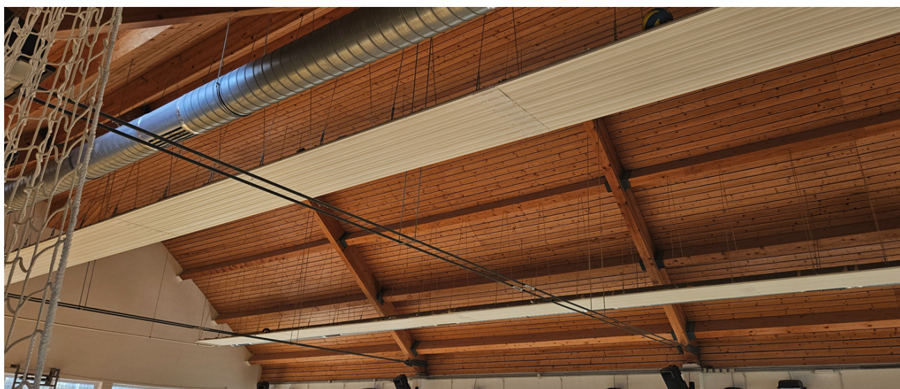
Slika 14: Stropna ogrevala v telovadnici
